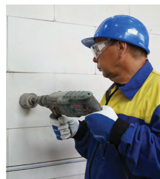
Vrtání otvoru pro elektroinstalační krabice
